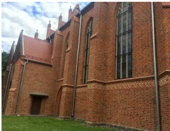
Fot. 2. Elewacja pld. z dekoracyjnym fryzem, po konserwacji (M. Gwiazdowska, 2020)
