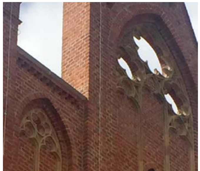
Fot. 6. Detal architektoniczny blendy po konserwacji. (M. Gwiazdowska, 2020)
